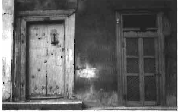
Resim 6 : Erzurum Evi'nde tırkiç uygulaması
