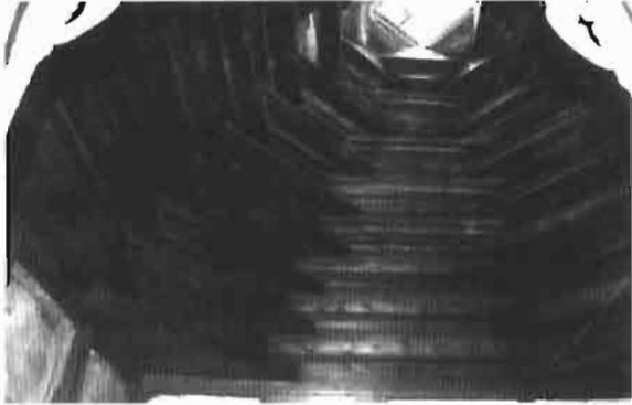
Resim 3 : Erzurum Evinde Tandirevinin klasik örtüsü olan kırlangıç örtü (Somunoğlu Evi)
